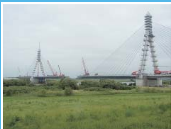
美原大橋の主橋梁部 （1面吊りの3経間連続斜張橋）
