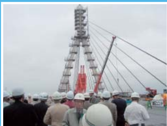
美原大橋の架橋現場 （上部工仮設等の説明を受ける）
