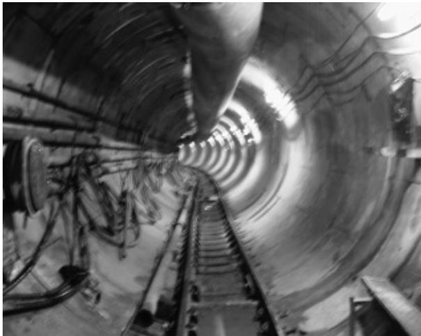
写真-5 トンネル断面(内径：3.7 m)：完成後400 kV、230 kV、66 kVのケーブルがこの中に設置される
