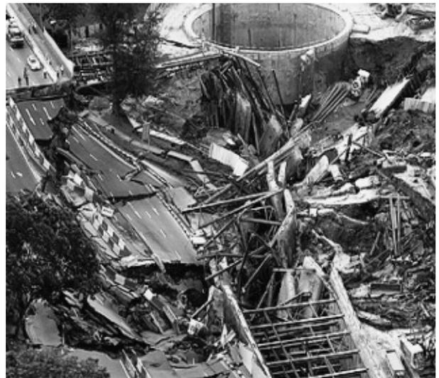
写真-1 崩壊現場状況(土留め壁崩壊により Nicoll Highway が幅 150 m、長さ 100 m、深さ 30 m 陥没)<sup>2)</sup>
