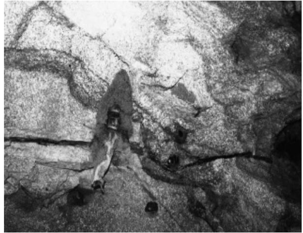
写真-6 花崗岩の状況(茶褐色の部分は風化作用を受けて変色しており、亀裂が発生している。亀裂の黒色は、MC グラウトの跡。完全に止水されている。)
