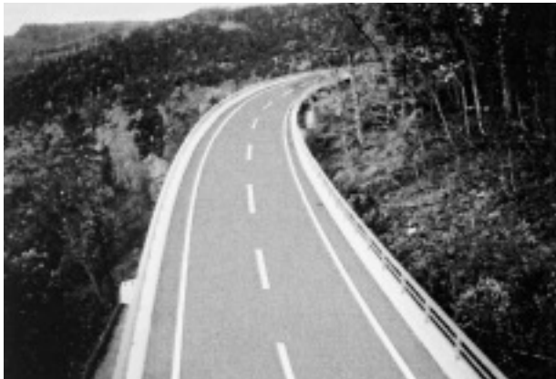
朝里峠付近山腹沿いを走る山岳橋
