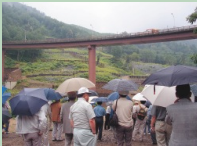
地すべり対策工が整備された斜面 (地すべりを抑止する鋼管土留柵工が見える)
