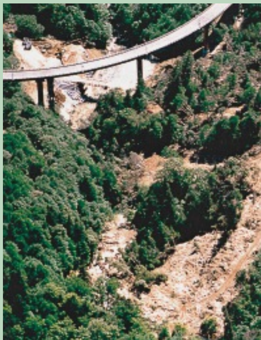
地すべり発生直後の斜め空中写真：北海道森林管理局資料 (地すべり土塊は無意根大橋付近まで達した)
