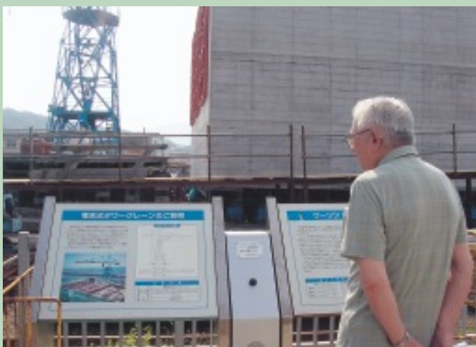
ケーソン製作用斜路の見学
