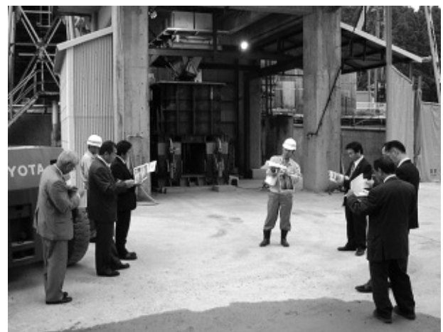
アッシュクリート製作現場
