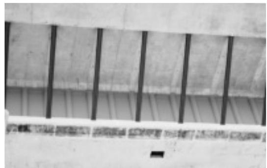
写真-3 プレート・鋼管ウェブとストラッド
