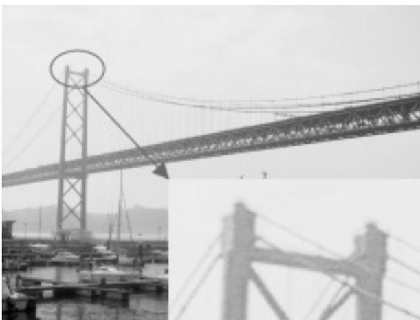
写真-6 追加ケーブル (上段)。吊り材は新旧
