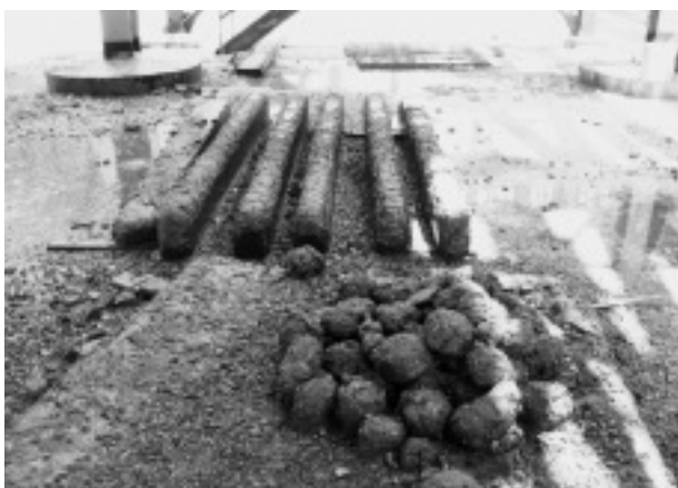
写真-5 MgCl_2 によるコンクリートの劣化 (曝露期間2年間で立方体が球状に)
