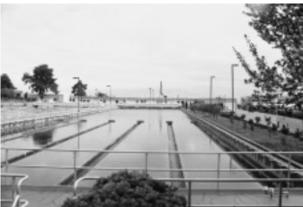
写真-11 ザイ浄水場
