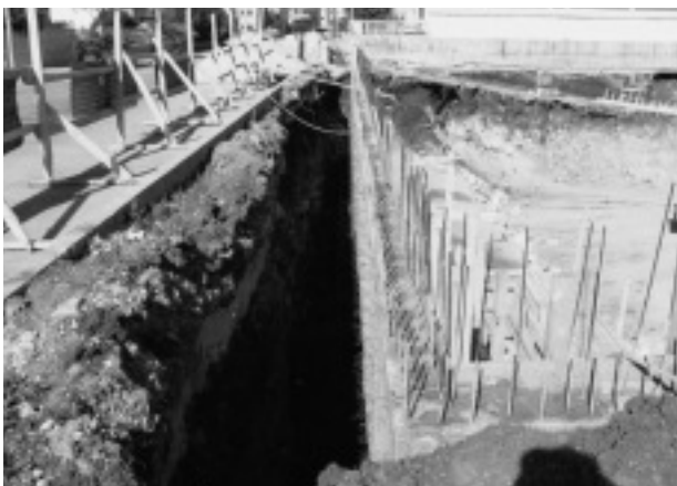
写真-7 配筋状況 (深さ 10 m 以上でも土留めは無い)
