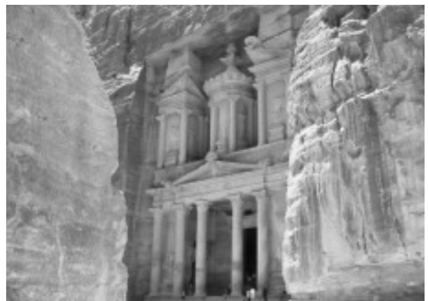
写真-8 世界遺産ペトラ エルハズネ神殿 (AD 363 年の地震で破壊)
