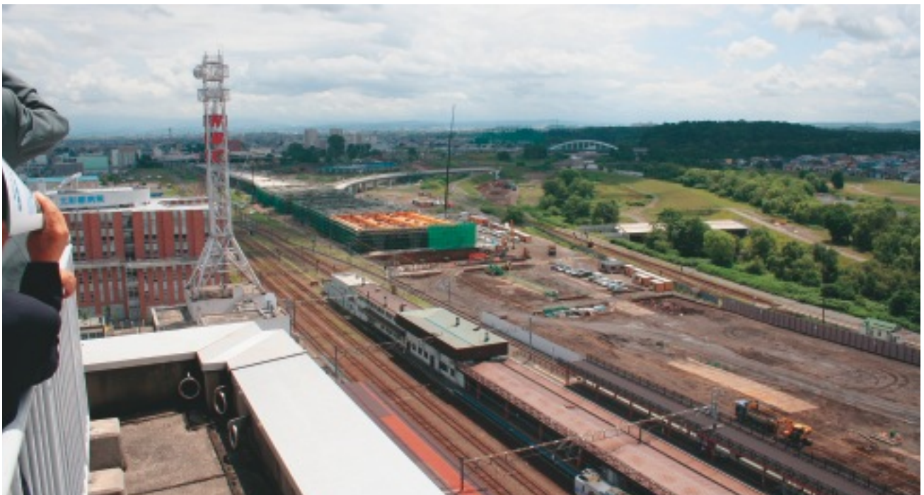
駅直結のホテル屋上から鉄道高架工事、新駅舎位置、忠別川河川敷を望む (正面遠方のアーチは新神楽橋)
