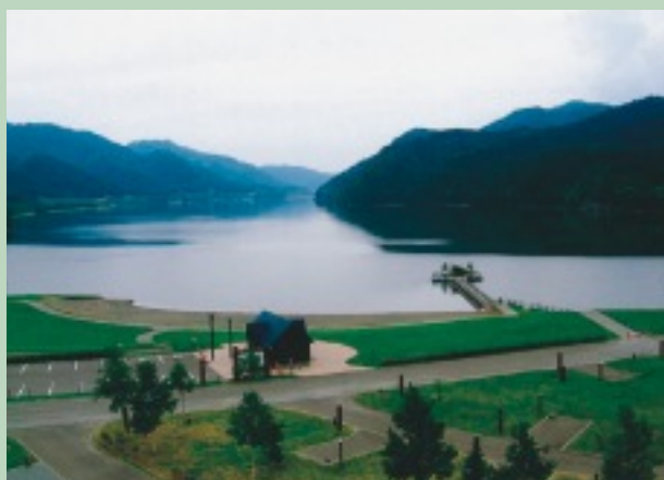
資料館より滝里ダムを望む
