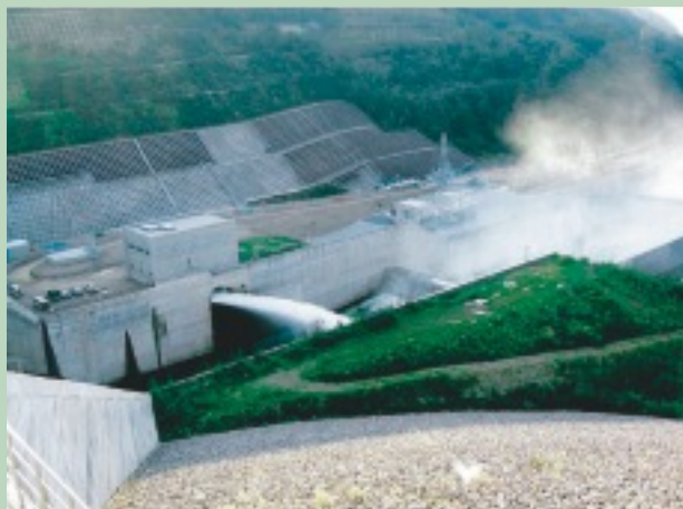
忠別ダムの放流状況
