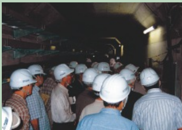
ダム堤体内で加賀所長より説明
