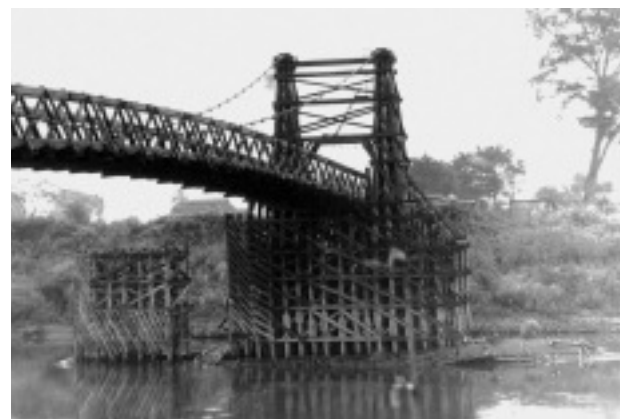
竣工した月形橋 昭和23年5月
