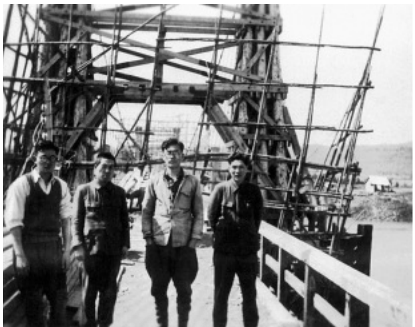
建設中の月形橋（右から二人目が堂垣内先生）
