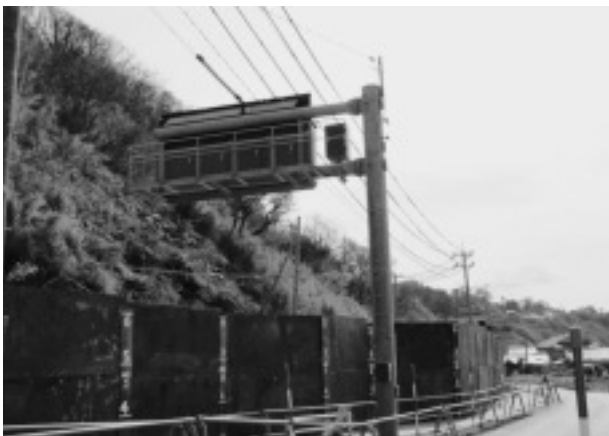
写真－12 国道 249 号輪島市大野町の道路崩壊 (カメラ監視で片側通行)
