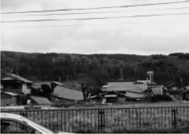
写真－7 輪島市門前地区の家屋崩壊 (軟弱地盤上の木造家屋に顕著に見られる)
