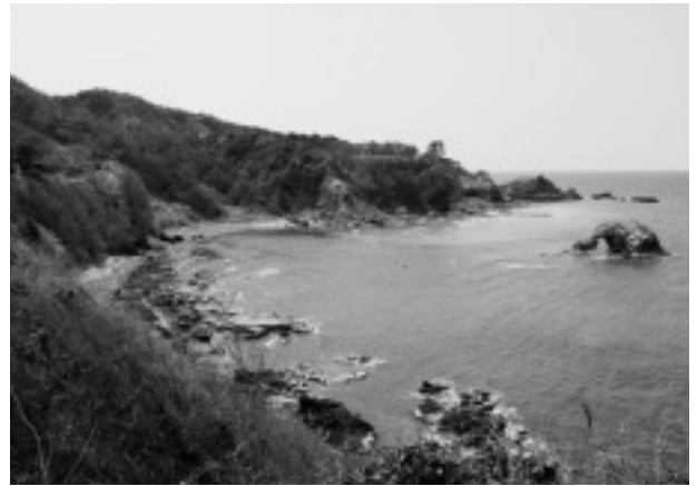
写真－４ 国道 249 号から能登金剛を望む (海岸線に 3 ヶ所の大規模崩壊が見られる)
