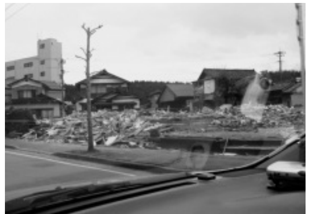
写真－14 穴水町大野地区の家屋崩壊 (既に家屋はかたづけられ近隣家屋の損傷も大きい)
