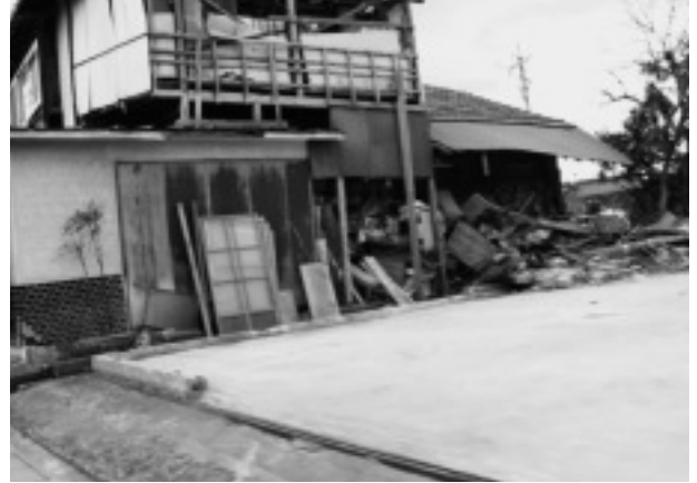
写真-17 穴水町留地地区の家屋崩壊 (近づくといよいよ損壊が見られる)
