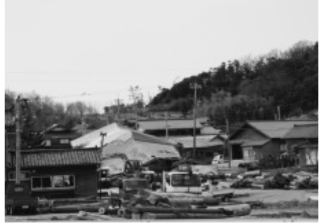
写真－8 輪島市門前地区の家屋崩壊 (地区内の家屋調査は実施済みで危険度が高い)
