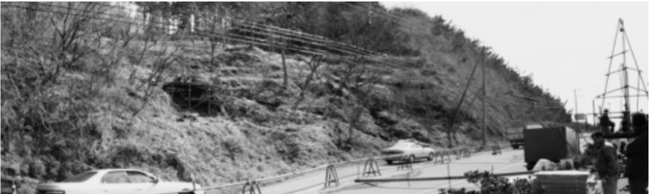
写真－9 国道249号輪島市深見町の道路崩壊 (地滑りが国道を押している)
