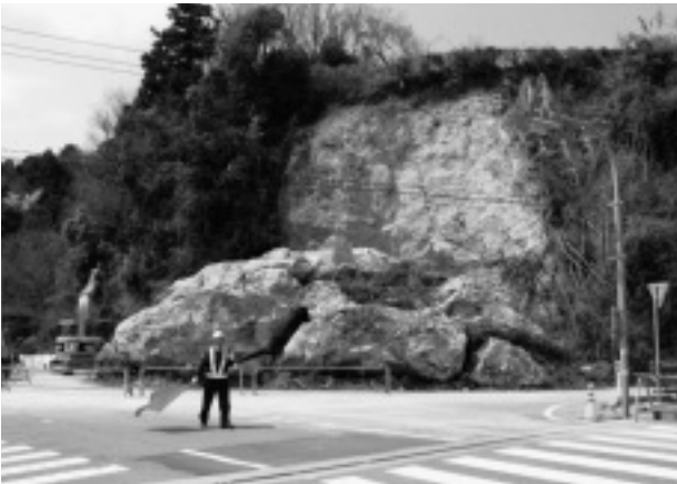
写真－２ 志賀町富来地区酒見原付近市道に及んだ落石 (設置されていたのり枠を巻き込んだ崩落)
