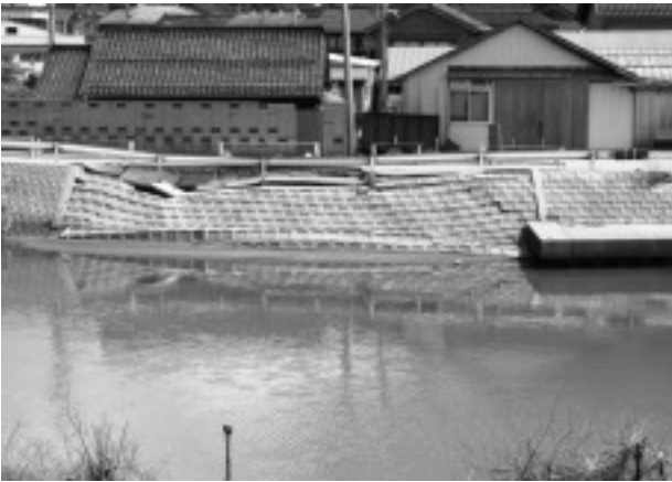
写真－１ 志賀町富来地区領家町 富来川護岸の損壊 (河口付近の砂地盤の流動化が見られる)
