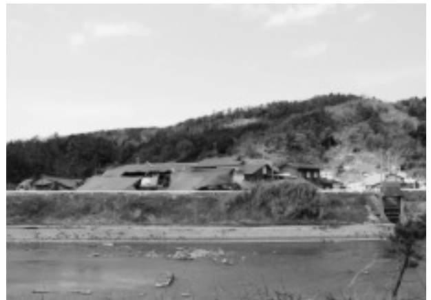
写真－６ 輪島市門前地区の家屋崩壊 (ハヶ川沿いの沖積平野に多く見られる)
