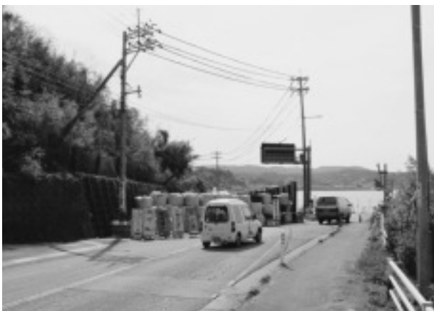
写真－13 国道 249 号輪島市大野町の道路崩壊 (カメラ監視で片側通行)
