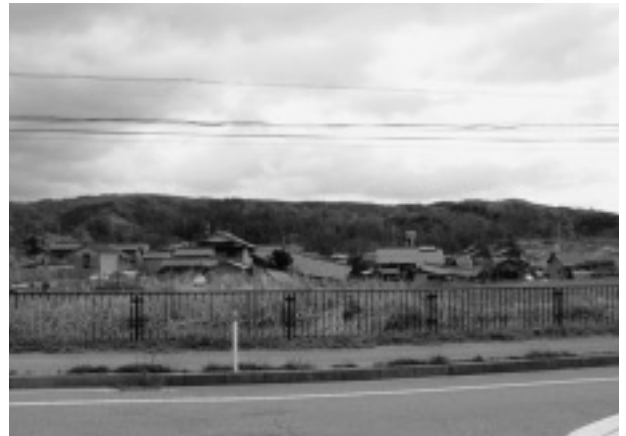
写真－５ 輪島市門前地区の家屋崩壊 (門前地区の建物が多く被害を受けている)
