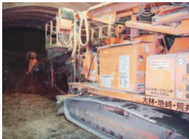
旭川トンネル 見たことがない施工機械が並ぶ
