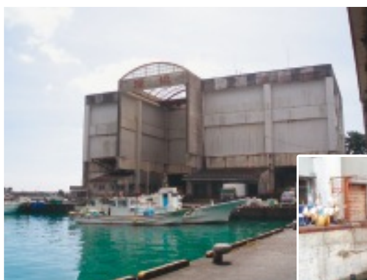
漁協の冷凍冷蔵施設
