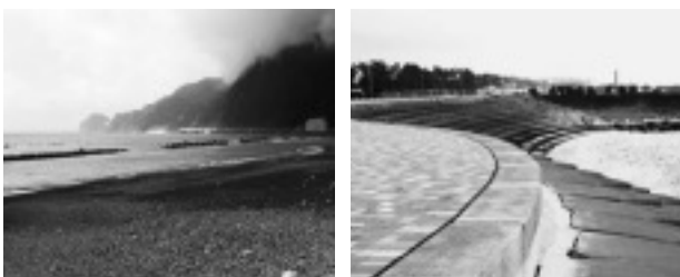
写真-2 海岸保全施設の状況
