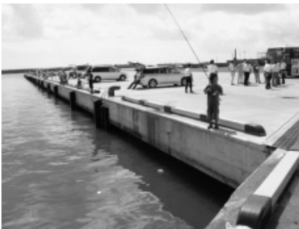
-9.0 m 岸壁（ジャケット式栈橋工法）
