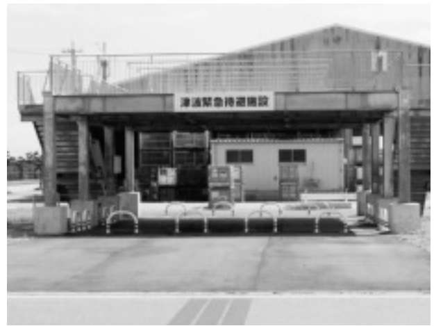
津波緊急待避施設
