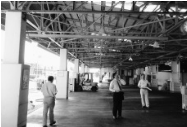
高架下の荷捌施設
