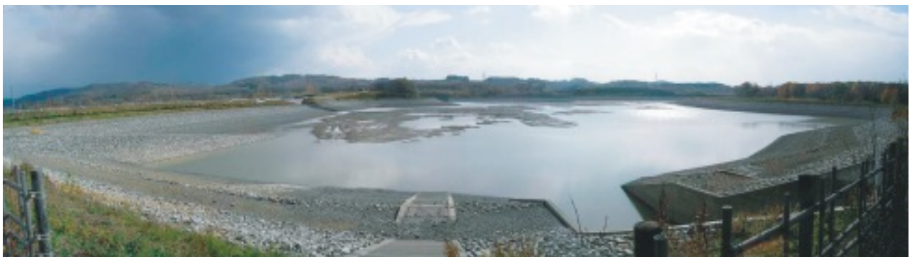
① 北海幹線用水路 光珠内調整池
