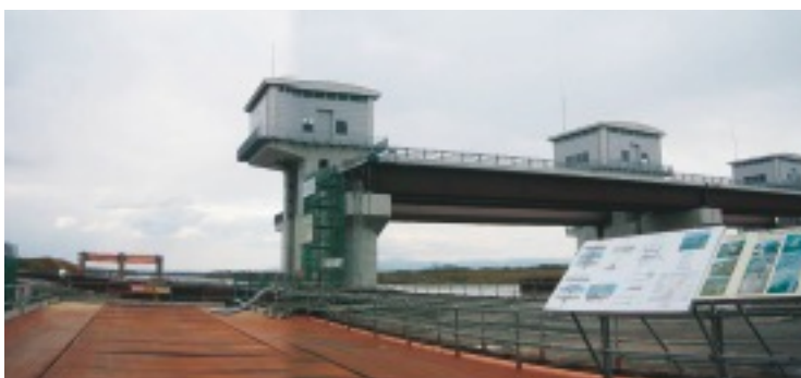
③ 石狩川頭首工（中央部の完成状況）
