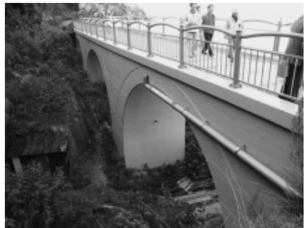
写真－1 下風呂温泉アーチ橋
