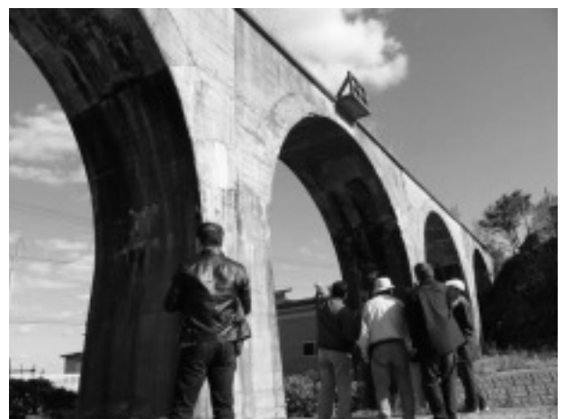
写真－2 二枚橋橋梁
