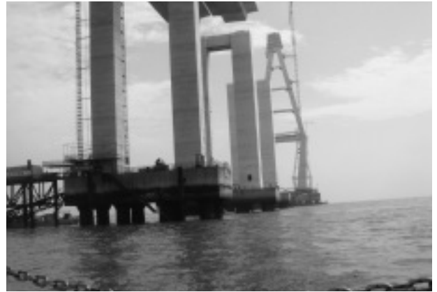
写真－5 仁川大橋
