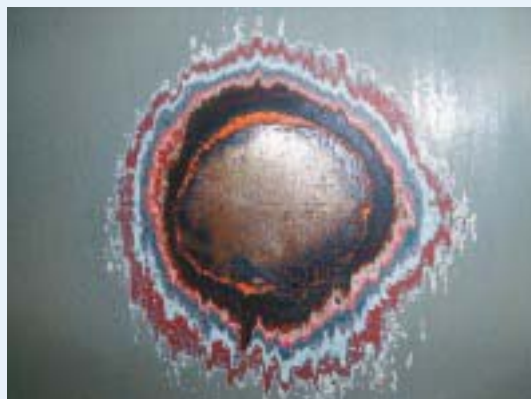
旭橋塗装工事現場 今回除去する昭和7年から何回も塗り重ねられてきた歴史的塗膜状況
