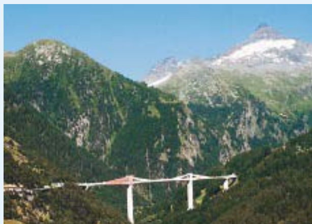
■アルプス山脈を背に全景を見る 完成して28年。大掛かりな修繕工事を実施中。
