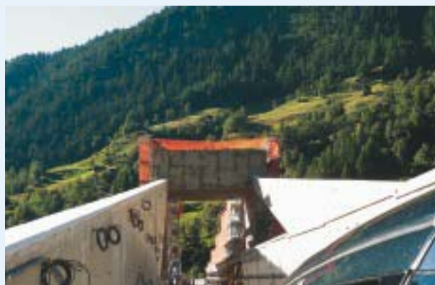
■S3タワーの補修作業 通行規制し、ひび割れ注入作業を行っている。
