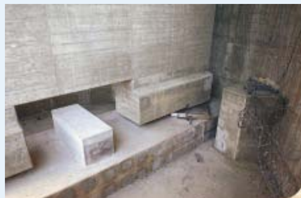
■S6橋脚の基礎（竹割り基礎の中をのぞく） 橋脚の荷重はどのように基礎へ伝わるのか？
