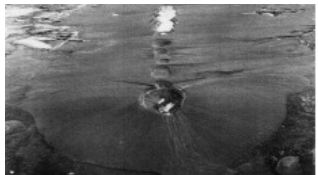
写真-1 液状化による噴砂跡 (釧路沖地震における釧路港)
