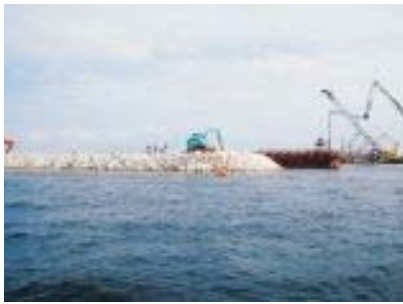
埋立部施工状況
