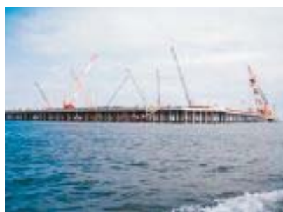
栈橋部施工状況
