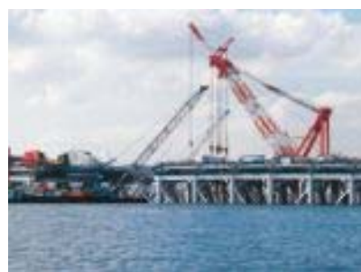
上部工施工状況
