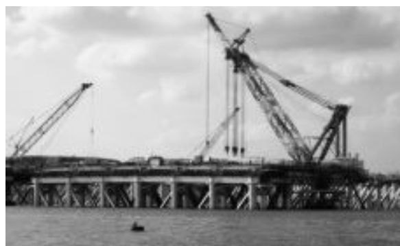
写真-1 D滑走路建設工事現場
