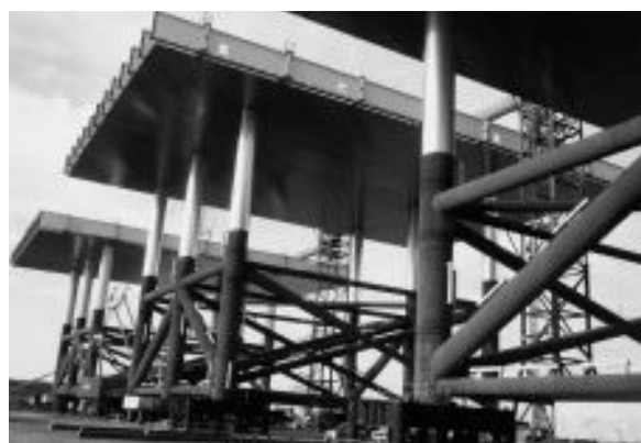
写真-2 富津ジャケットヤード
