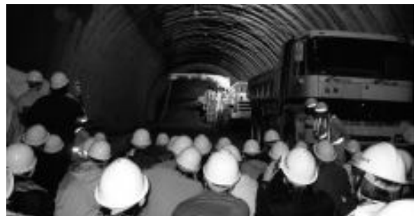
トンネル切り羽部の掘削工事の見学
