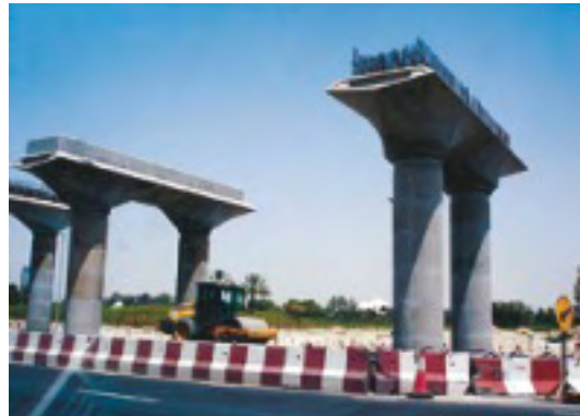
ドバイ市内の メトロ建設工 事現場
