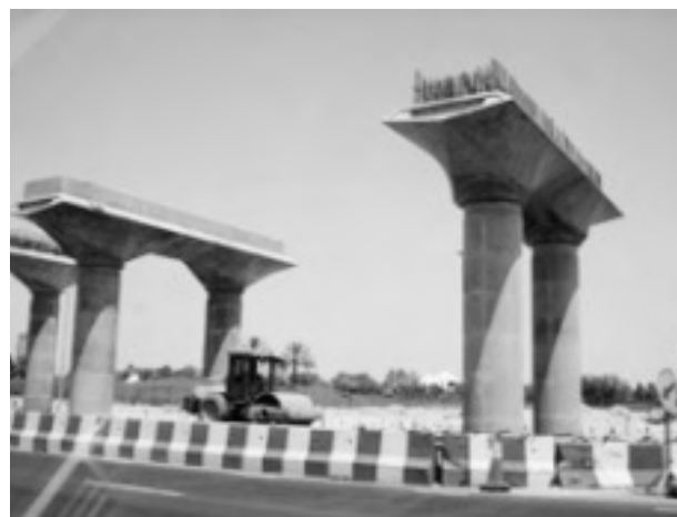
図-2 ドバイ市内のメトロ建設工事現場(1)
