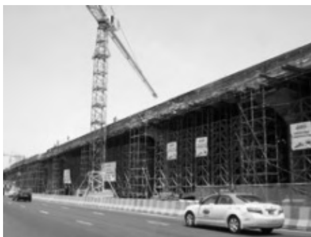
図-3 ドバイ市内のメトロ建設工事現場(2)
