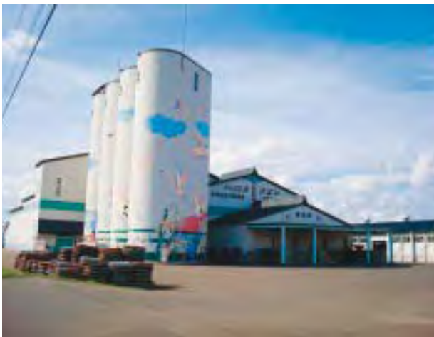
米穀雪零温貯蔵施設全景
