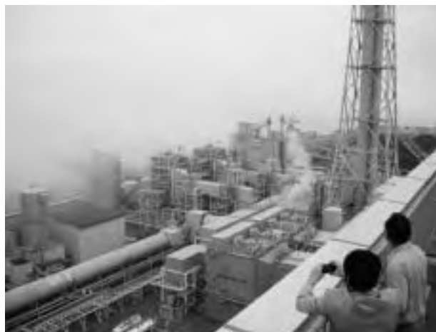
2 号発電機屋上より施設全景を展望
