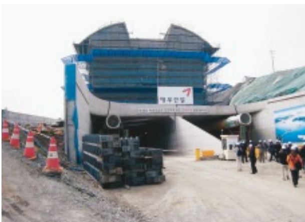
プロジェクトで建設中の沈埋トンネル抗口部
