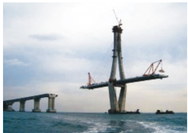
建設中の斜張橋上部施工の様子
