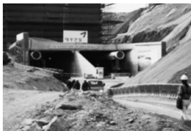
写真-3 沈埋トンネル抗口部
