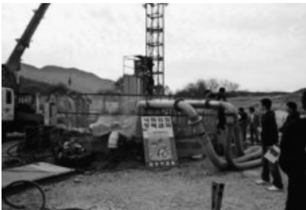
写真-2 集水井掘削現場
