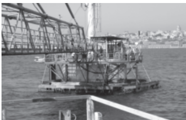
写真16 ボスボラス海峡地下鉄工事(ここから海面下)
