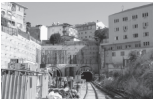
写真17 ボスボラス海峡地下鉄工事(海峡よりアジア側、JR西日本可部線 カベ を廃止した際の発生レールを工事用レールとして再利用しているとの由)
