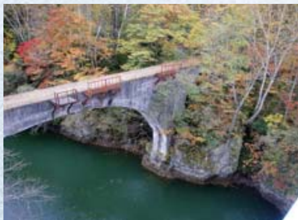
10 / 9 【第三音更川橋梁】
