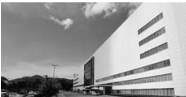
写真-8 シャープ亀山工場
