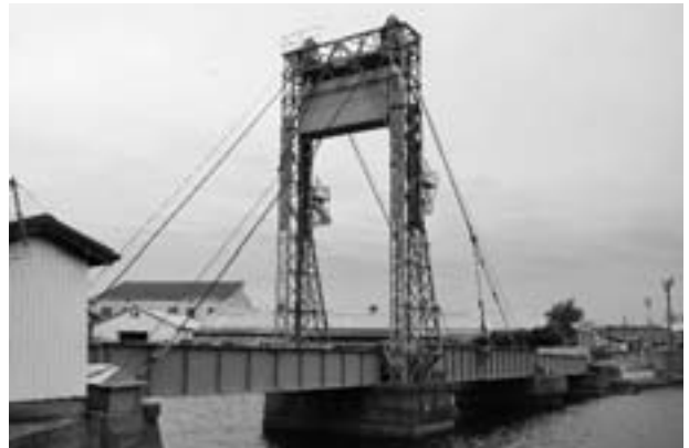
写真-10 末広橋梁(現役最古の鉄道可動橋)
