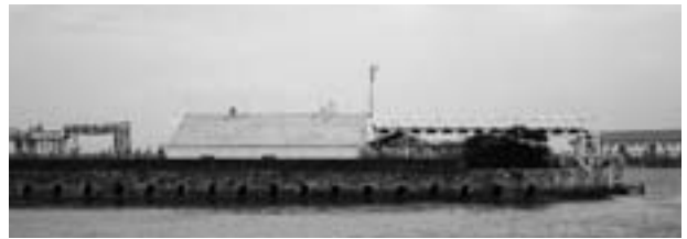
写真-9 潮吹き防波堤(明治26年に築造)
