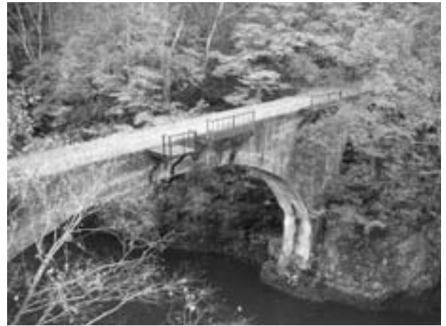
第三音更川橋梁
