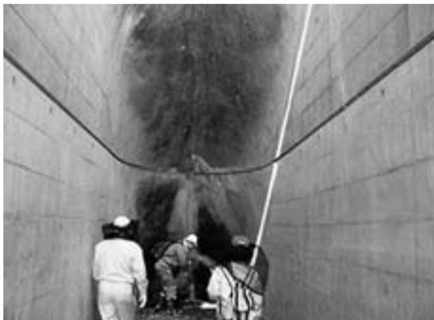
ところで、ダムの定期点検では、堤体の変位量や漏水量をチェックしなければなりません。笹流ダムのようなバットレス式ダムでは、堤体内部が外側から閉ざされているわけではありませんので、点検方法がどうやっているのか不思議に思っていました。変位量観測については、堤体から独立した観測所から、定点調査をしているようですし、また、漏水量の観測についても知ることができました。それは、扶壁と扶壁の間にある幅 2 m 程度の空間に吐出管が出ていて、そこから漏水量を測ると言うことです。
