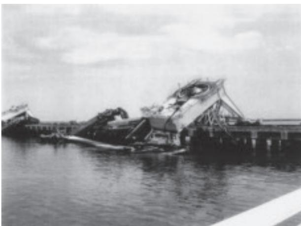
原町火力発電所 アンローダーの被災状況
