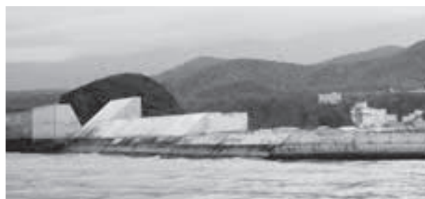
写真6 半没水上部斜面堤の状況
