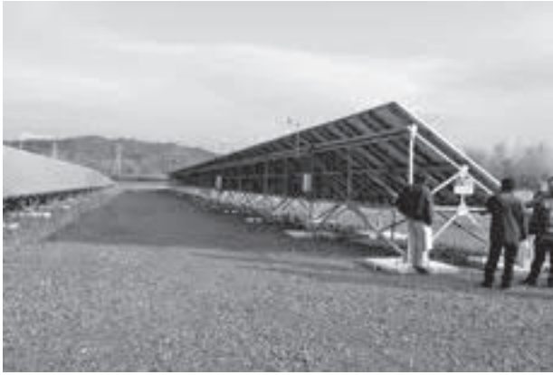
太陽光モジュールの基礎
