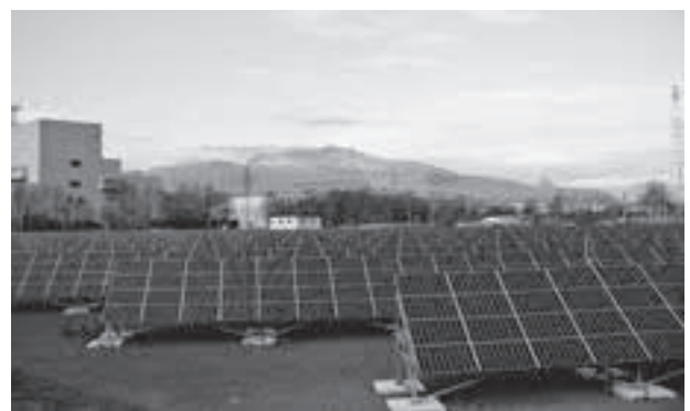
有珠山を望む伊達ソーラー発電所
