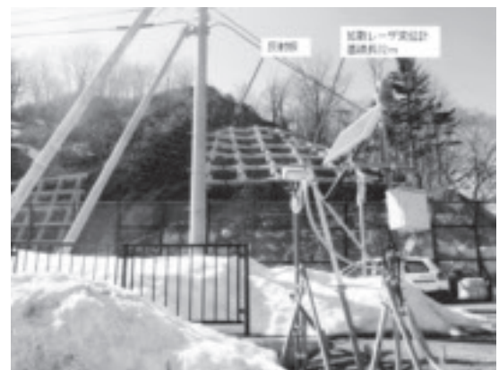
写真-4 「拡散レーザ変位計」本体設置事例(地すべり対策工施工管理)
