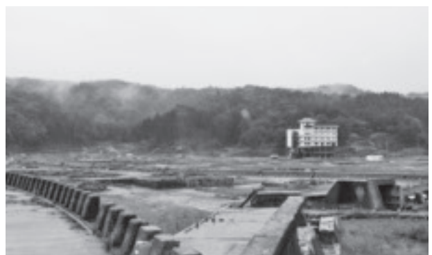
写真10 防潮堤分岐部から「たろう観光ホテル」を望む
