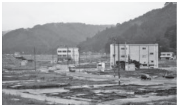
写真9 宮古市田老総合事務所庁舎から望む
