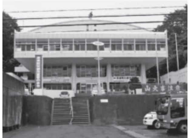
写真8 宮古市田老総合事務所庁舎
