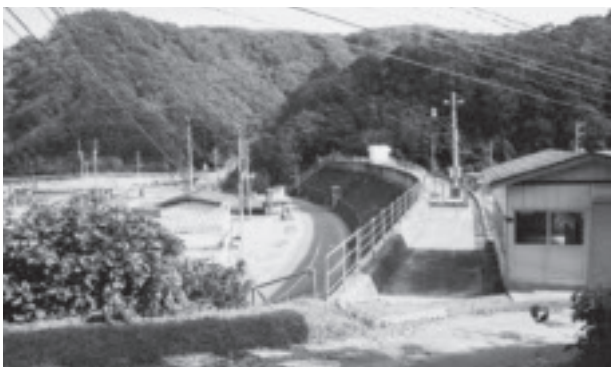
写真3 太田名部防潮堤
