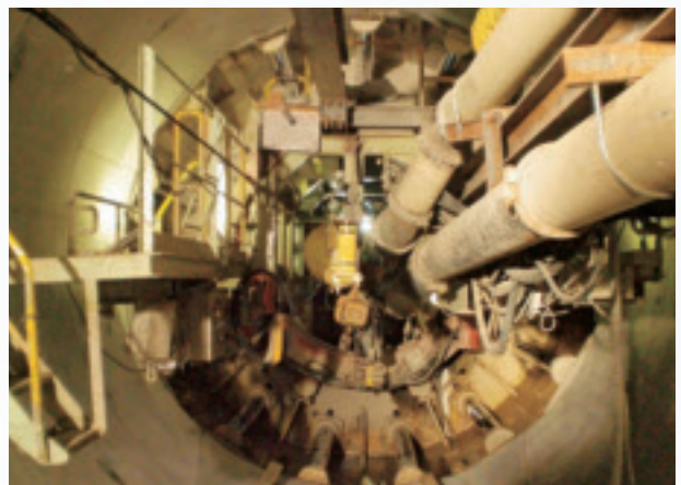
切羽(地中掘削部)
