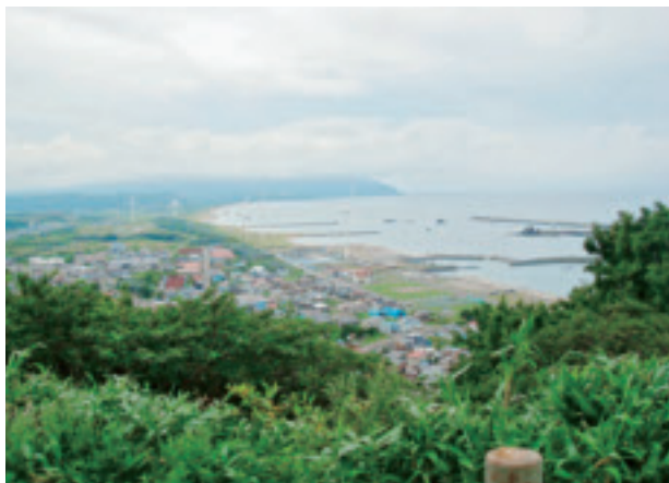
陸上風車『瀬棚臨海風力発電所』(手前)と 洋上風車『風海鳥』(奥防波堤付近)
