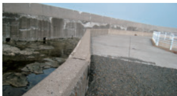
網走港帽子岩ケーソンドック周辺部の防波堤
