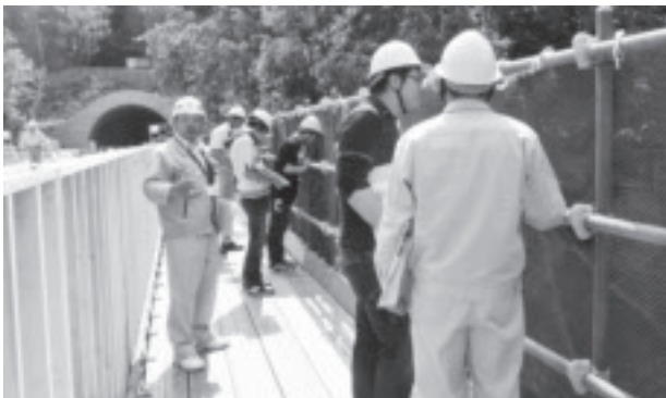
写真-3 寺の沢川橋の上部側方通路(足場)
