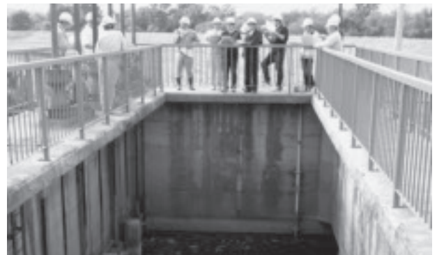
写真-5 排水機場の排水施設
