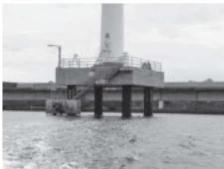
写真-2. 洋上風車の基礎部
