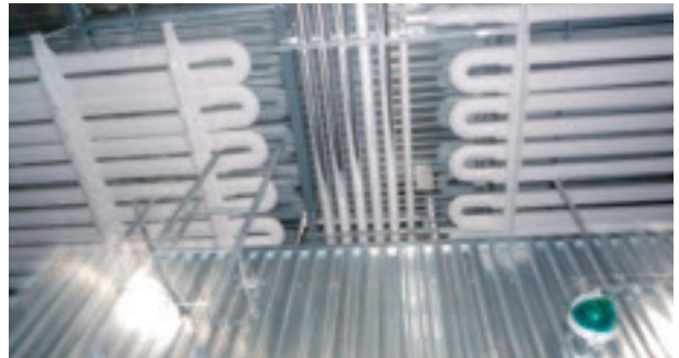
水産加工業協同組合 大型冷蔵倉庫の様子④
