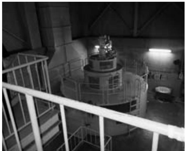
写真-8 カプラン水車を用いた豊浦発電所の発電機
