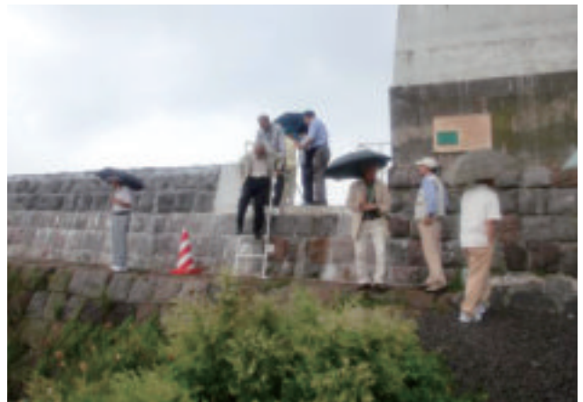
【改修された函館入船間漁港防波堤②】
