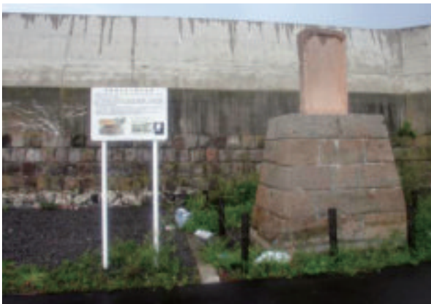
【改修された函館入船間漁港防波堤①】
