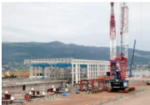
【新函館駅(仮称)建築工事の状況】
