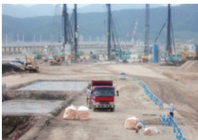
【軟弱地盤対策での地盤改良の状況】
