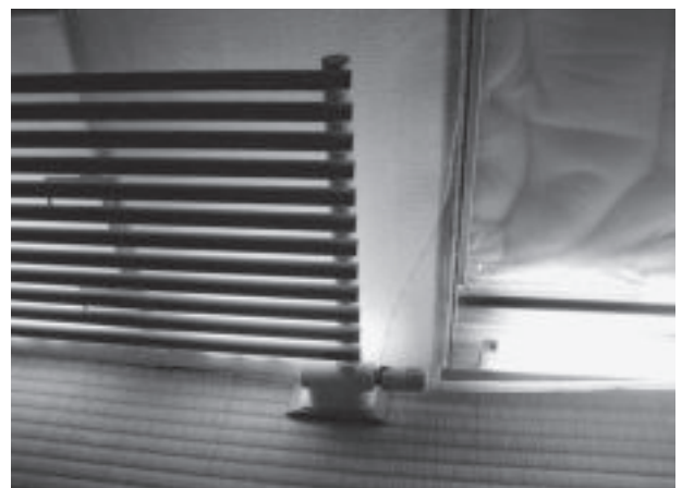
写真-5 壁材のダブルスキンと温水ヒーター
