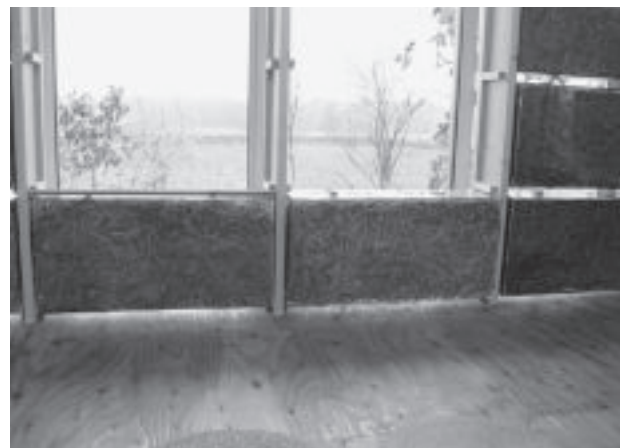
写真-8 牧草を収めたケースが壁兼用の熱源
