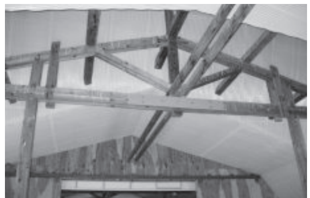
写真-2 ラボ棟 2 階の小屋組
