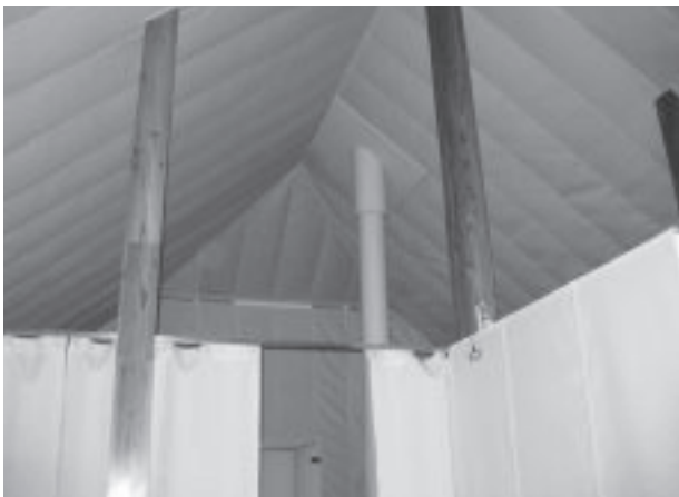
写真-3 Mème 屋根材のダブルスキン(二重構造)
