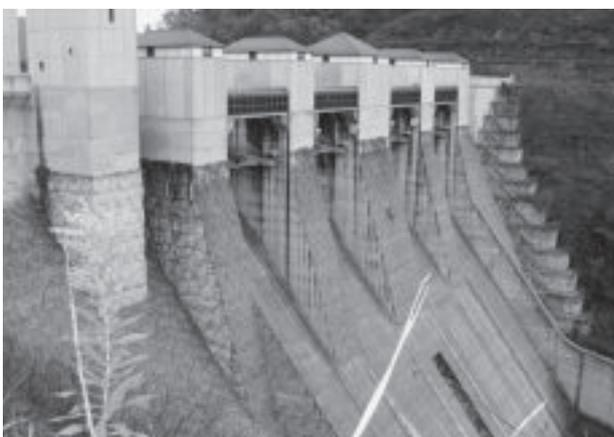
写真-3 三春ダム 堤体(化粧型枠使用)
