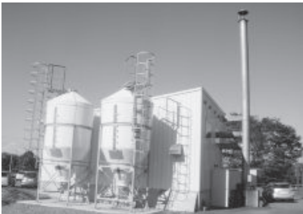
写真-6 ボイラ建屋全景
