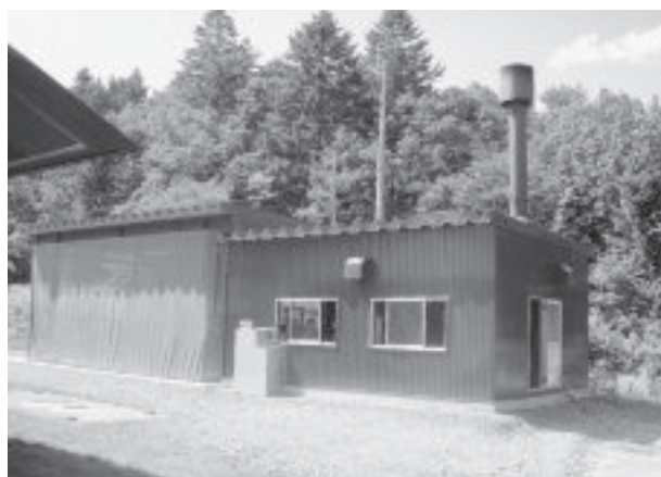
写真-1 ボイラ建屋全景
